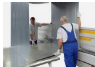
La produzione di condotti di grandi dimensioni è possibile con due soli operatori.
